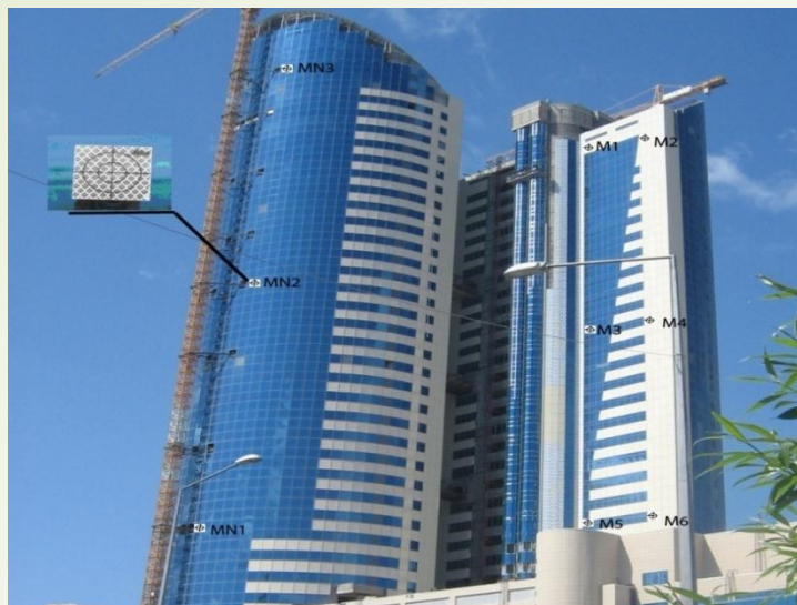
Қадағаланатын құрылысқа орнатылған бақылау маркасы
