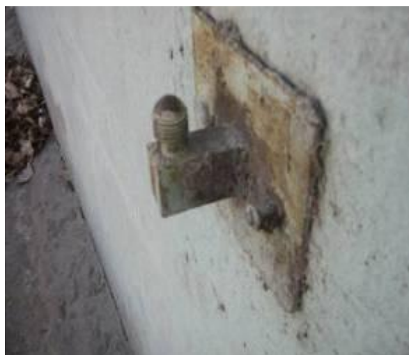
20 Сурет – Мониторингтік призма және шөгу маркасы
