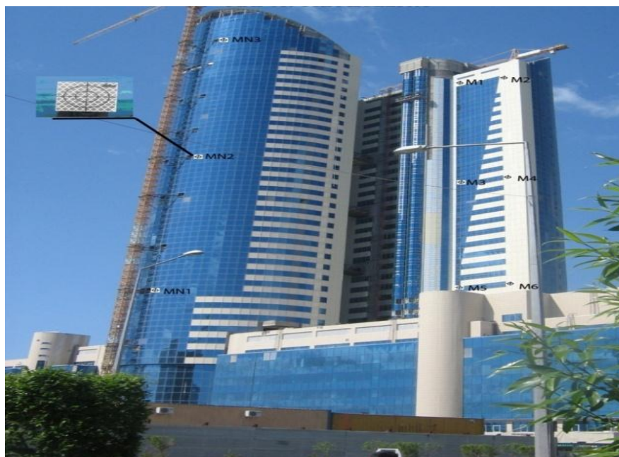
19 Сурет – Ғимараттағы бақылау маркаларының орналасуы
