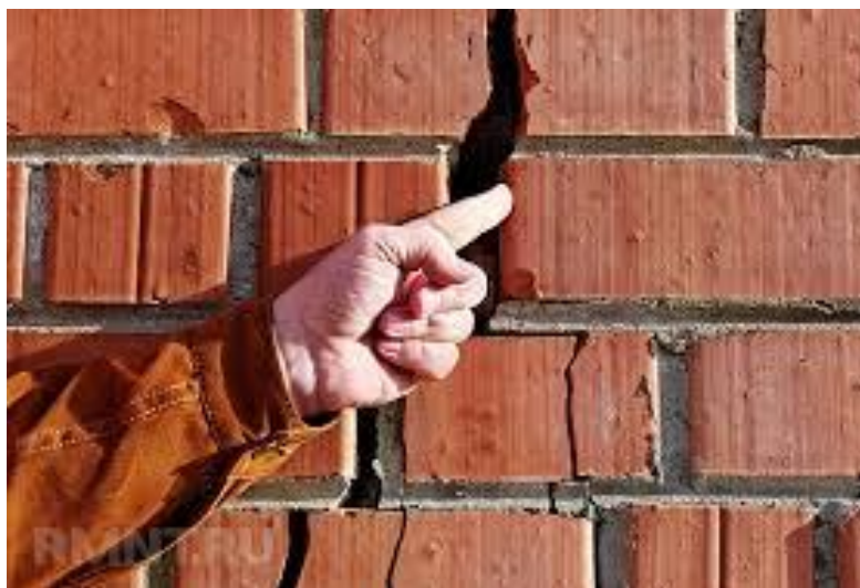
18 Сурет – Инженерлік құрылыстар деформациялануының әсерінен пайда болған жарықшақтар
