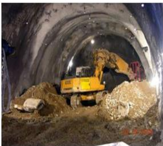
6 Сурет – Liebherr R932 экскаваторы және «Meuco Suprema» машинасы
