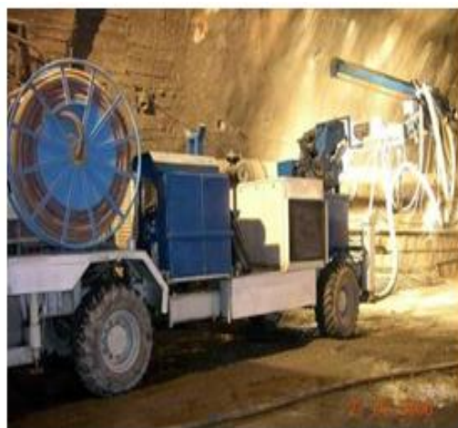
6 Сурет – Liebherr R932 экскаваторы және «Meuco Suprema» машинасы
